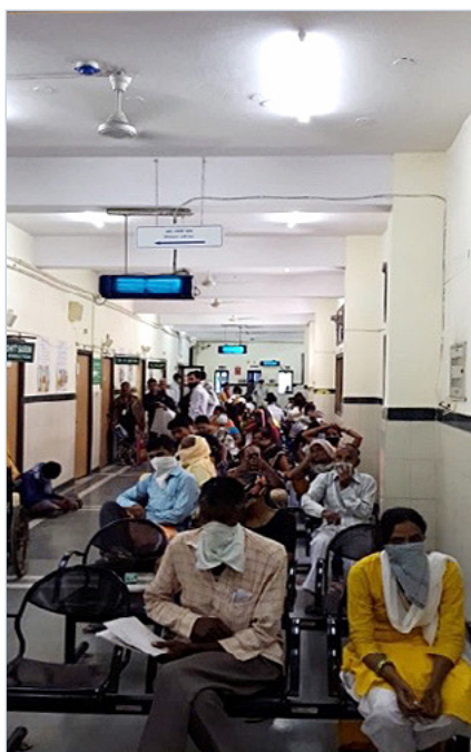
РИСУНОК 1 Зал ожидания амбулаторного приема с естественной вентиляцией, потолочными вентиляторами и БУФ облучателями в верхней части помещения. Национальный Институт Туберкулеза и Респираторных Заболеваний, Нью-Дели, Индия.
