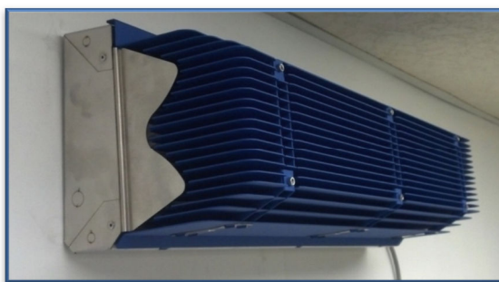
Рисунок 1 Слева - пример открытого сверху УФБИ облучателя верхней части помещения для помещений с высотой потолка 2,7 м (9 ft) и выше. Справа - пример УФБИ облучателя верхней части помещения с жалюзи для помещений с высотой потолка 2,4 м и выше.
