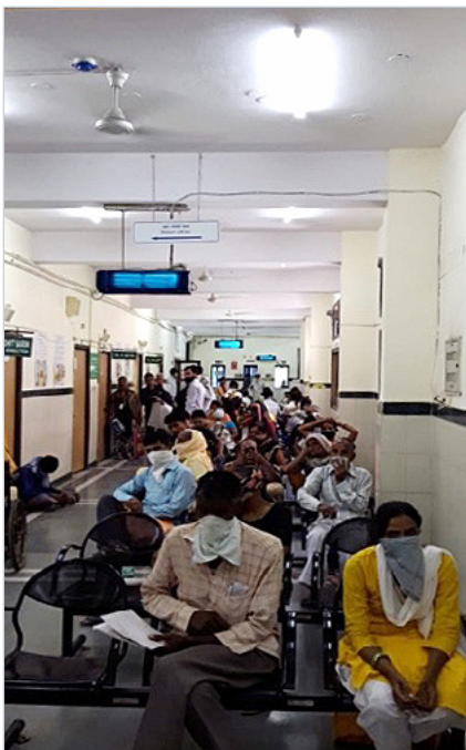
图 1 自然通风的门诊候诊室内配有吊扇和上层空间紫外线杀菌装置。印度新德里国家结核病和呼吸系统疾病研究所。
